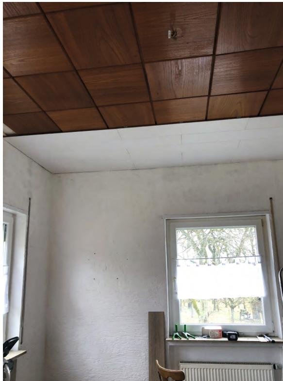
Alte dunkle Holzdecke wird durch weiße Deckenprofildecke ersetzt.
